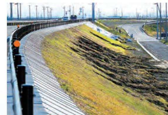
令和元年台風19号による豪雨の影響で、のり面の表土が流出する被害が発生。復旧作業などのため、当初10月19日に予定されていた全線開通および開通式典が延期された(2019年10月16日撮影)
