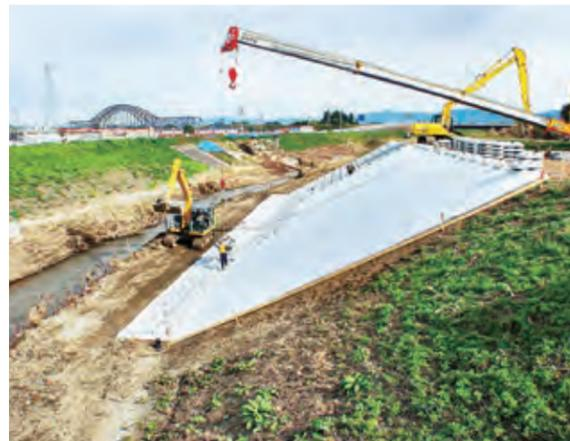
国が権限代行により、阿武隈川水系の堤防決壊箇所の応急復旧を実施。会員企業が24時間体制で作業を行った(上2019年11月3日、下11月4日撮影)
