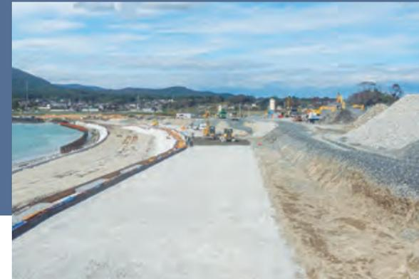
三島海岸(大谷海岸)の防潮堤工事では、林野庁で初めてCSGの技術を導入(2019年10月17日撮影)
