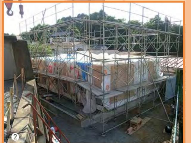
U & U工法の施工手順。工場生産されたユニットを積み上げて住宅をつくる。
