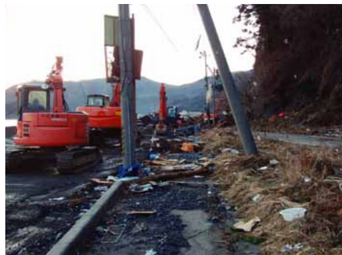
東日本大震災では地域建設業が誰よりも早く被災地に駆け付け、道路を使えるようにしました(石巻市雄勝町)
